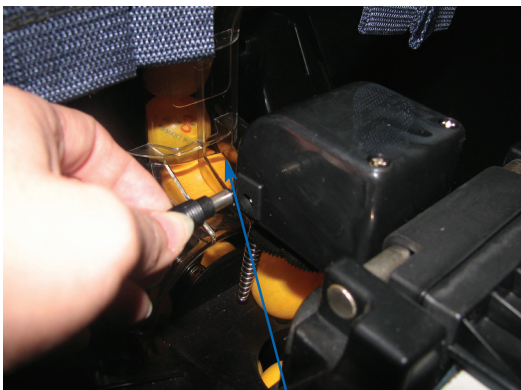
攪拌裝置電源線
